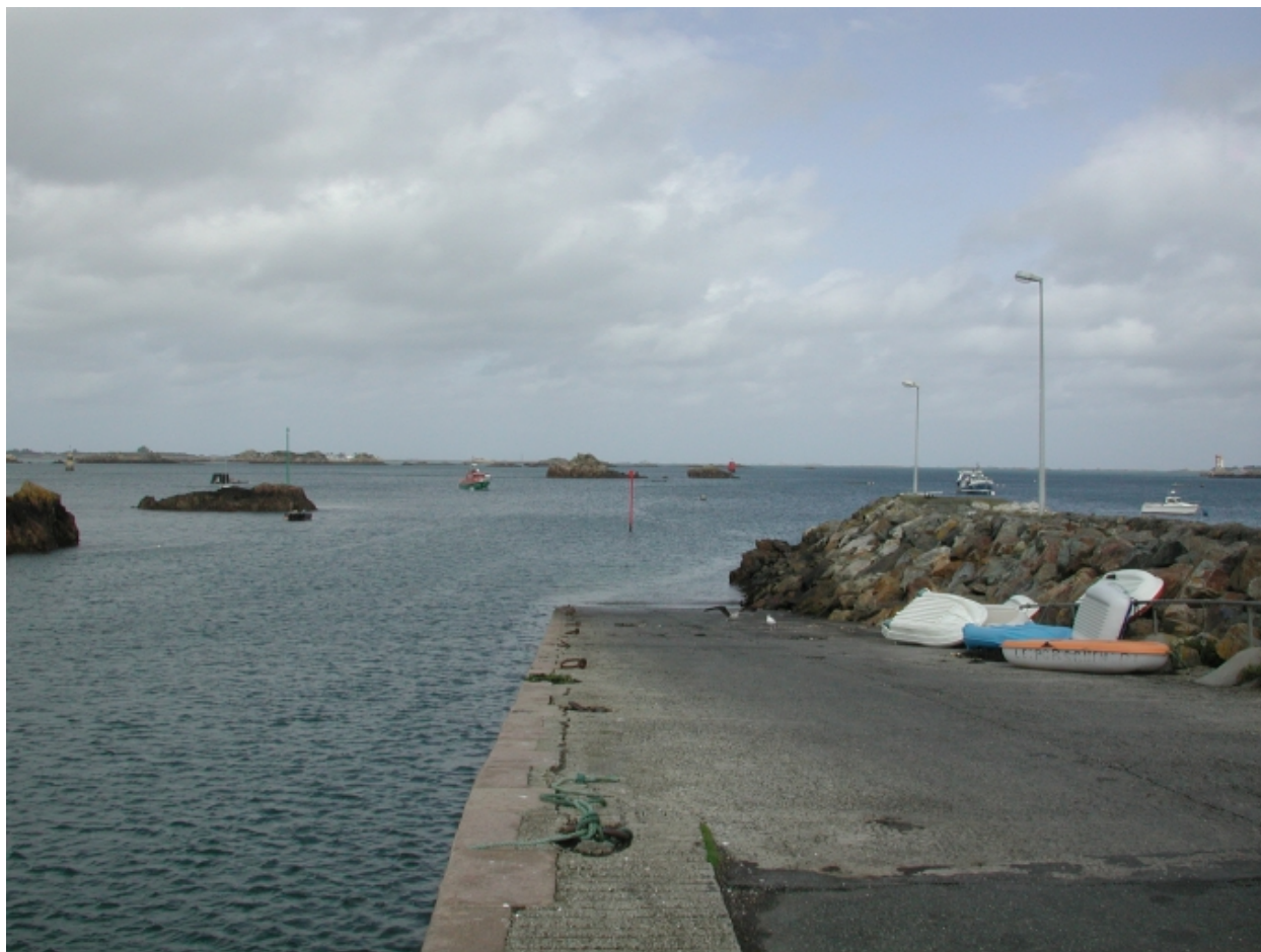
Vue générale de la nouvelle cale bétonnée à l'entrée du port
