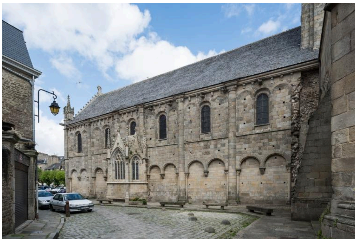
Vue biaisée du mur sud de la nef en 2019
