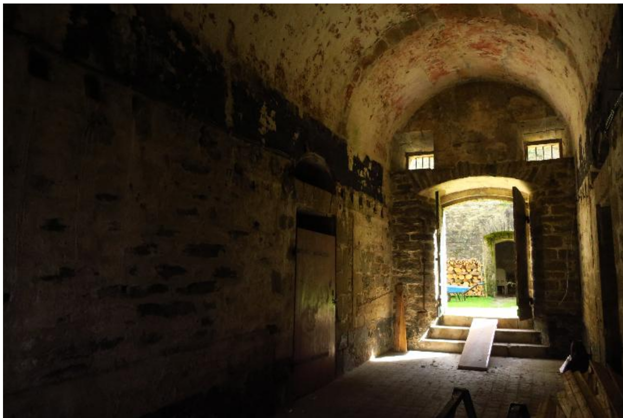
Le Palais, enceinte urbaine, réduit A, travée centrale.
