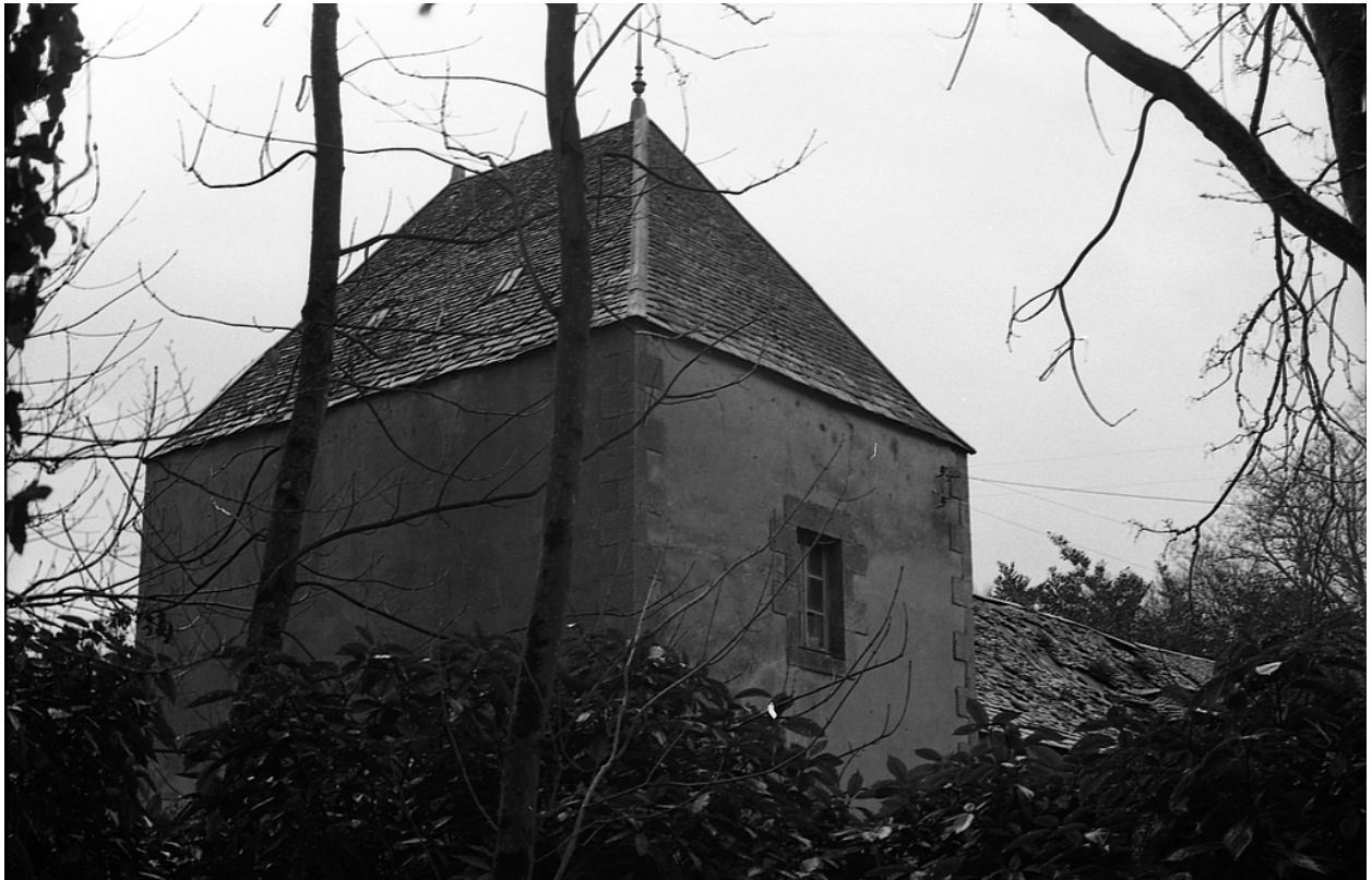
Communs, état en 1979, aile ouest, détail de la tour
