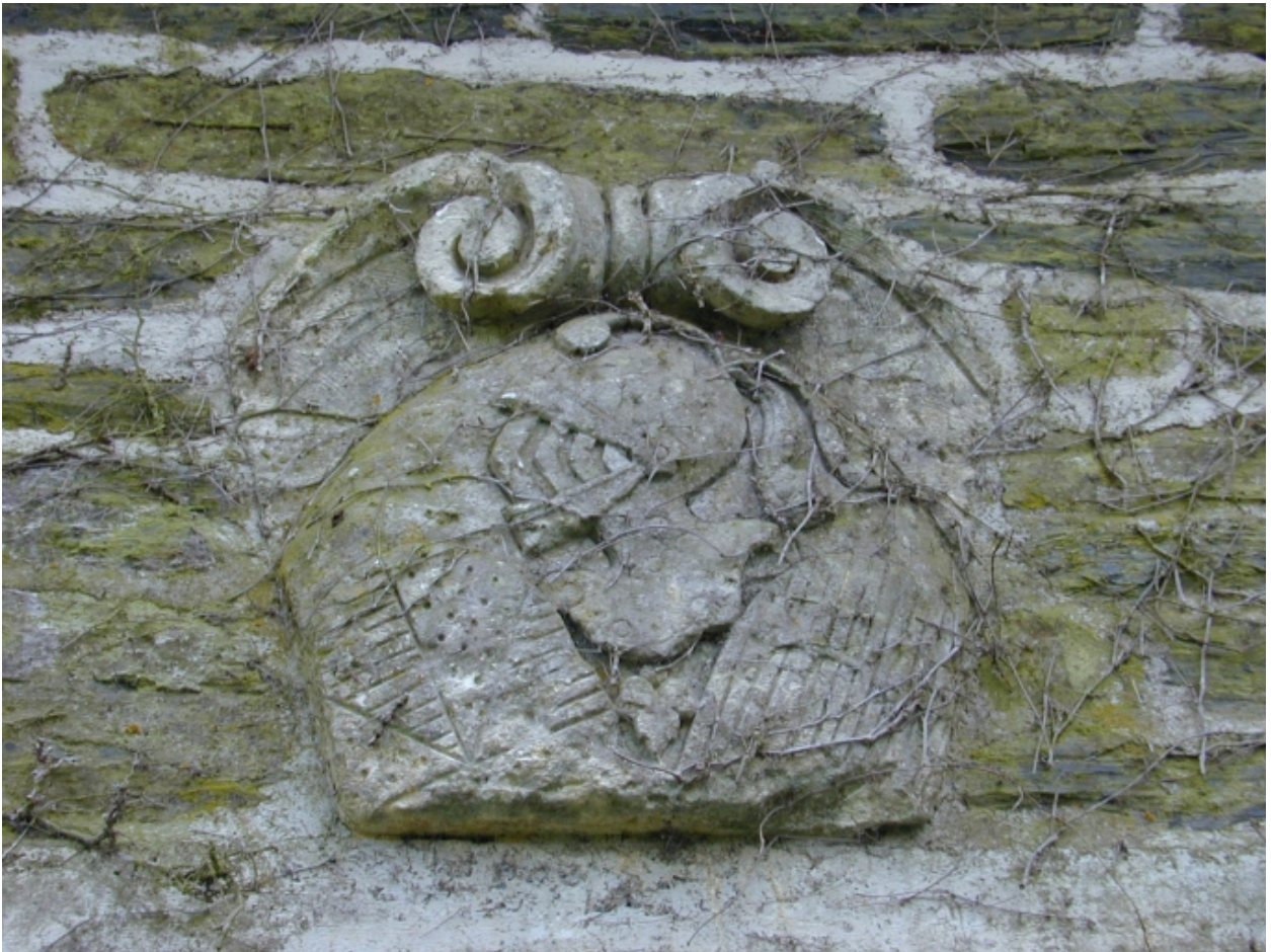
Détail d'une pierre sculptée remployée sur la remise à bois
