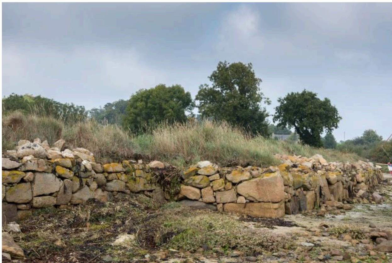
Vue d'ensemble d'un mur de soutènement composé de gros blocs de granite, sur la rive ouest de l'anse de Pelinec
