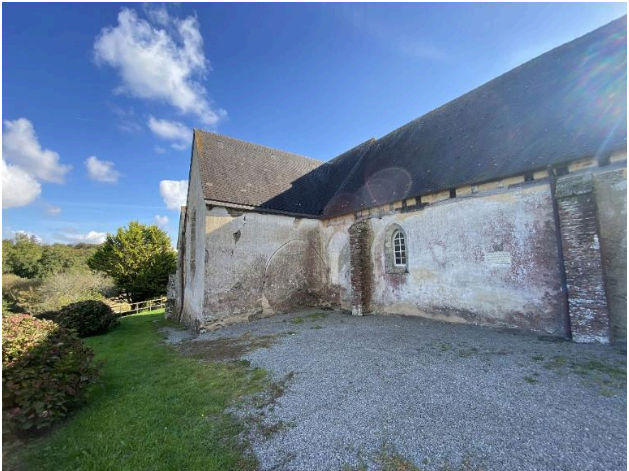
Élévation nord, vue générale
