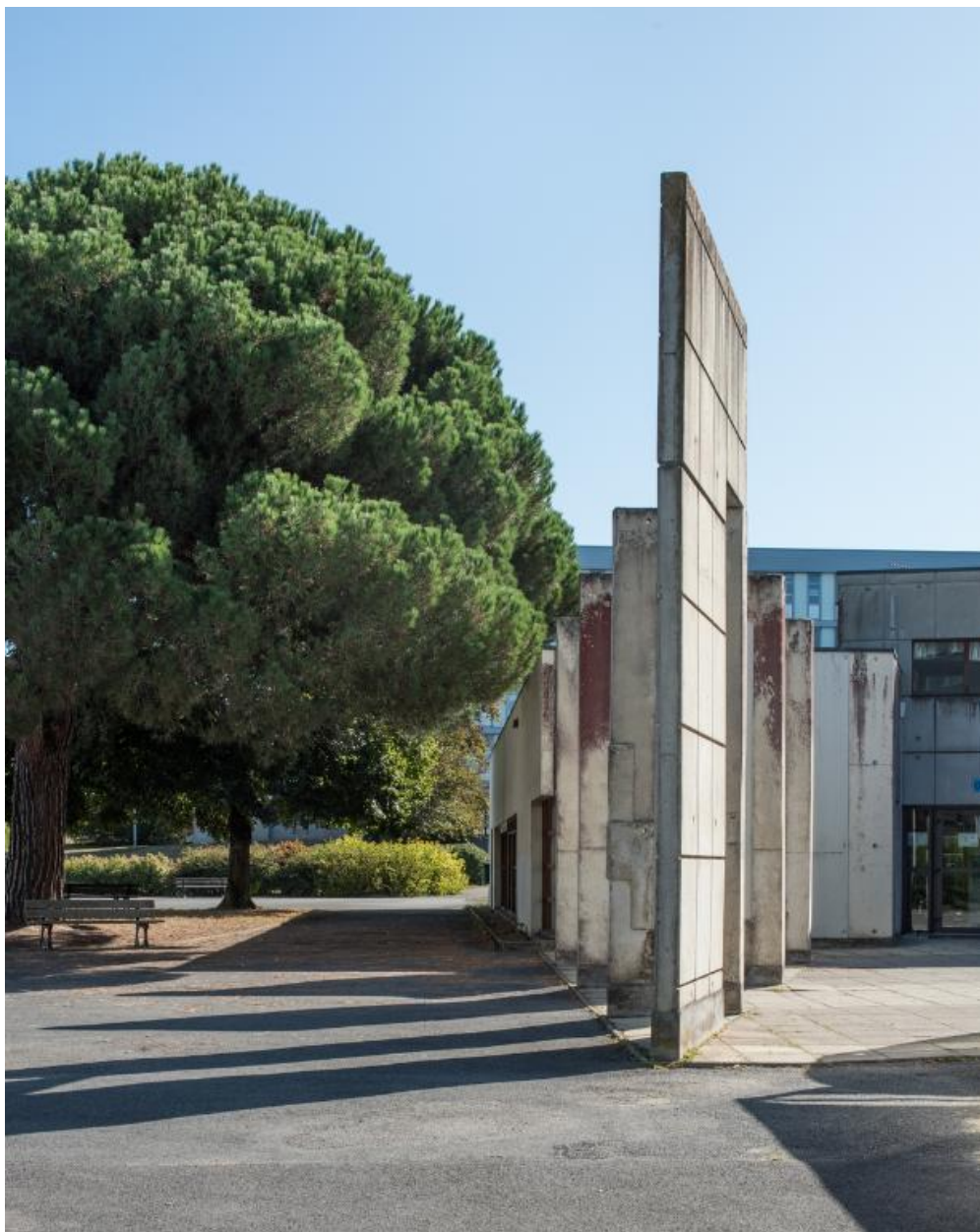
Bâtiment, centre de documentation et d'information. Détail sur l'entrée, vue prise de l'ouest.
