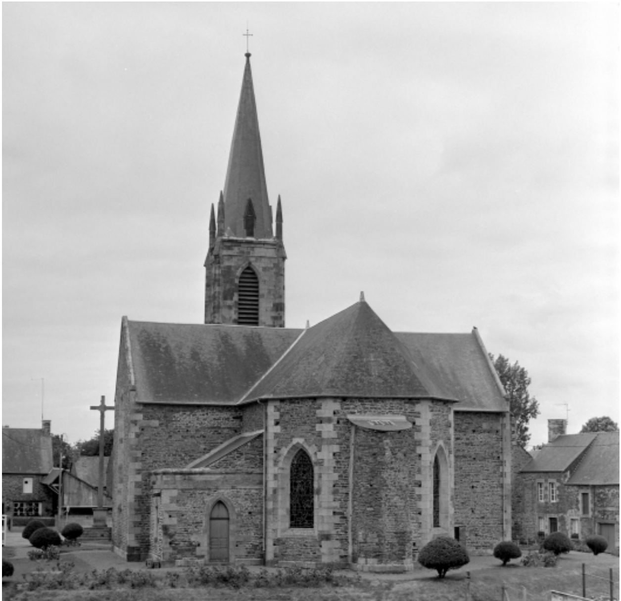
Elévation Est, chevet : vue générale
