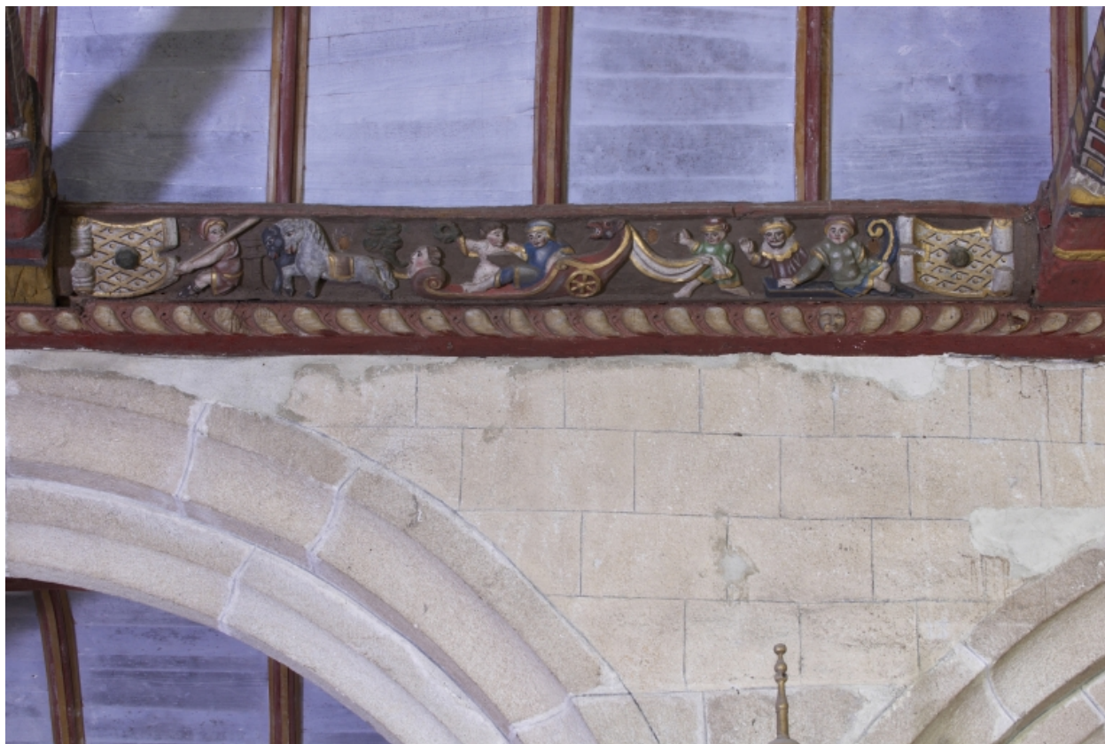
Intérieur, mur nord de la nef, détail de la sablière
