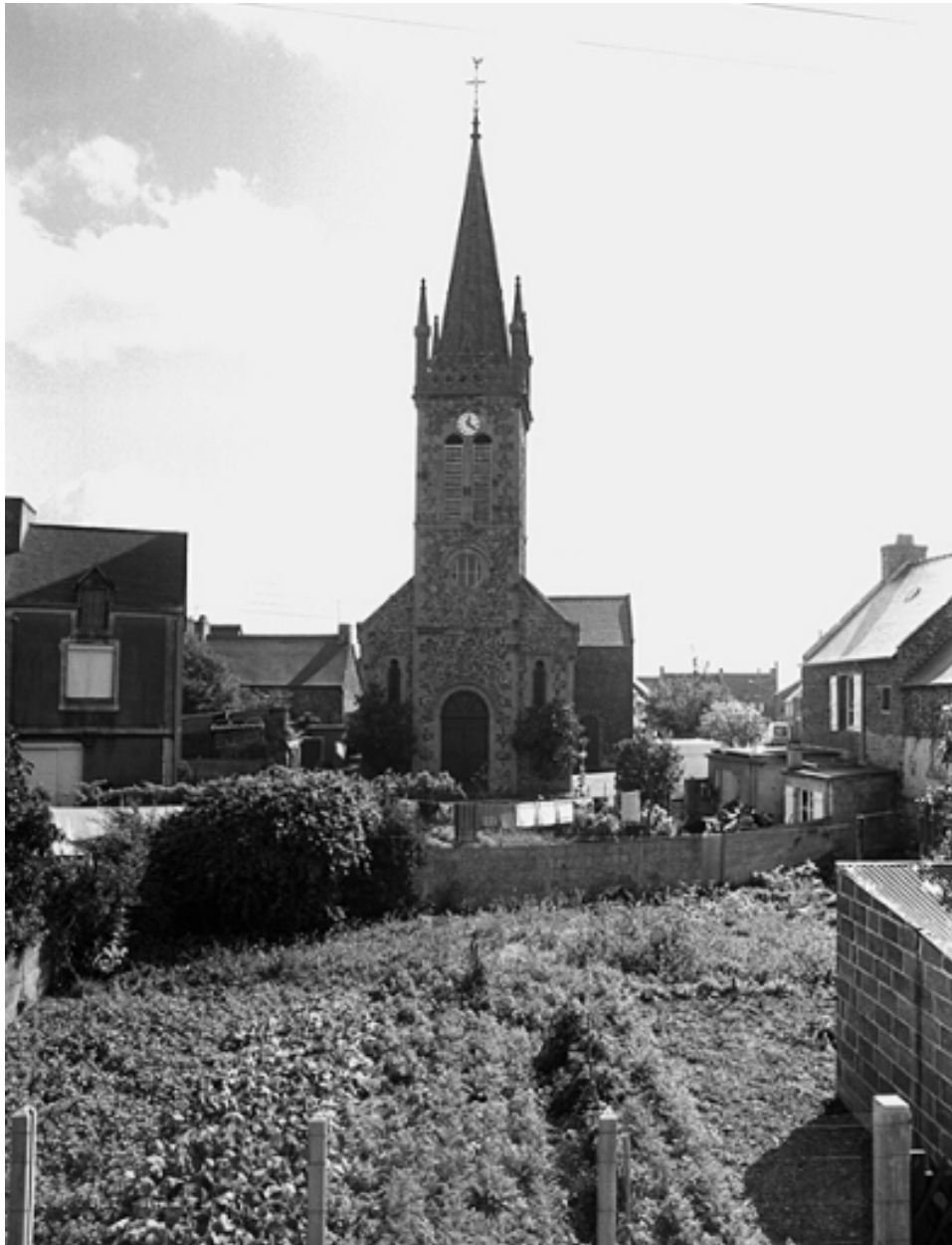
Elévation ouest : vue générale
