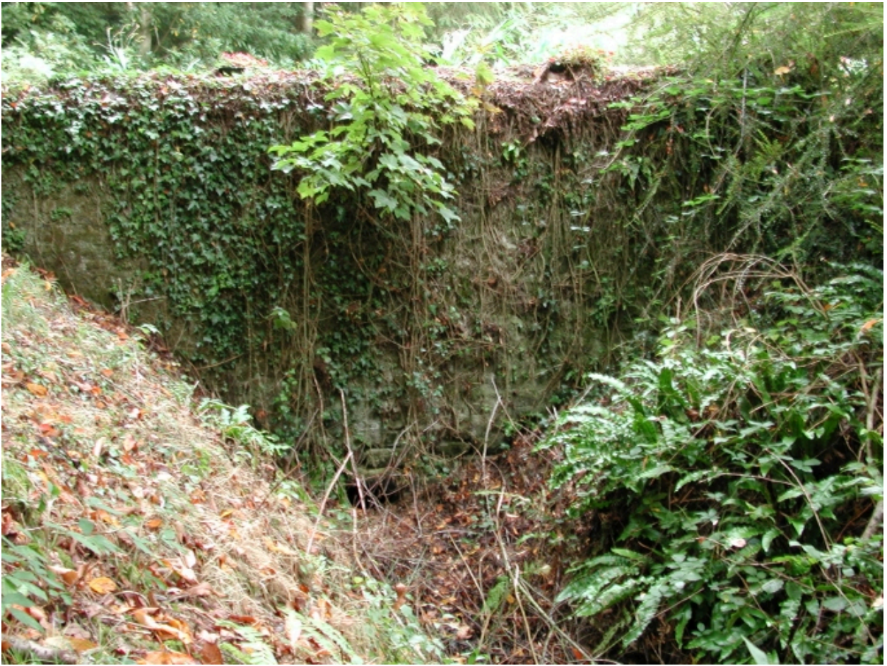
Ponceau au nord-ouest du site
