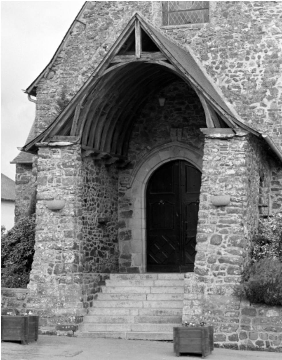
Elevation Ouest, porche : vue générale
