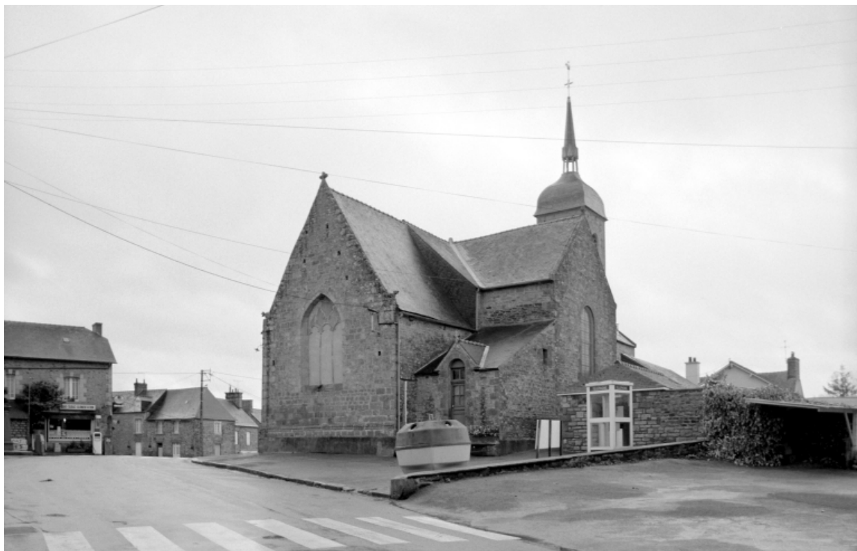
Elévation nord-est : vue générale
