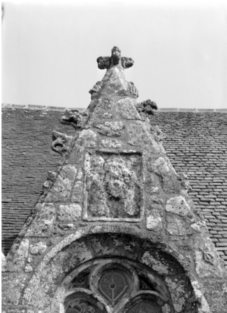
Nef, mur sud : pignon de la fenêtre en lucarne
