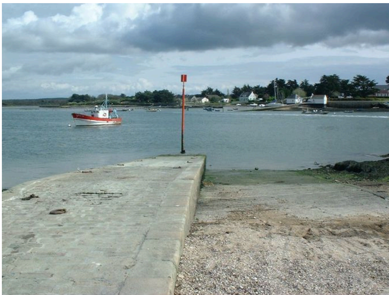
Cale du Passage Saint-Armel
