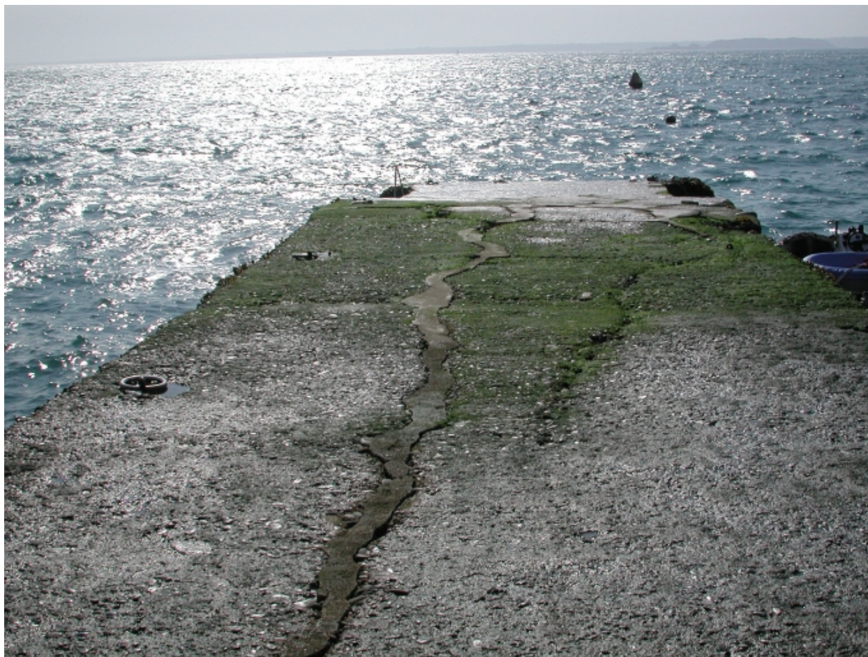
Vue de l'extrémité du quai sud
