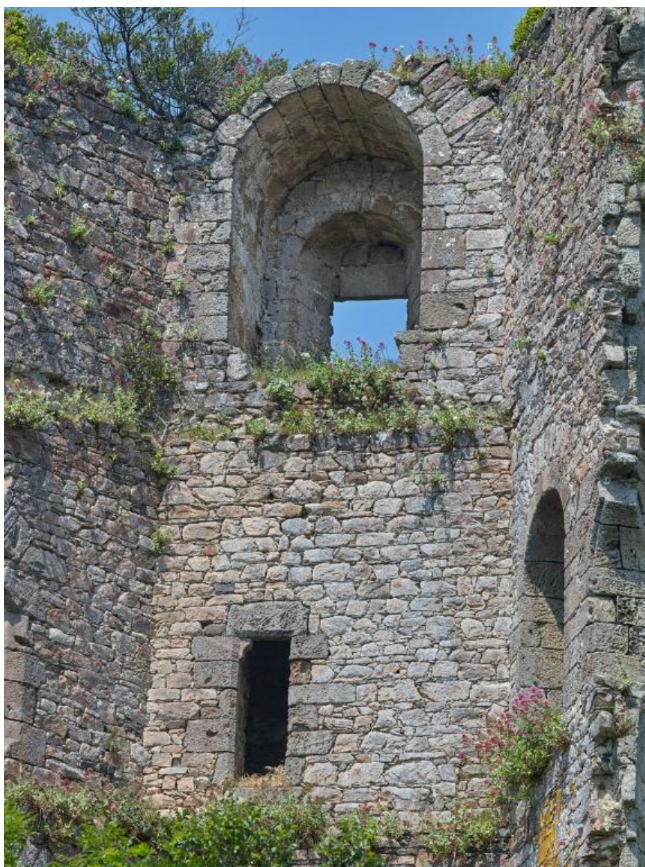
Vue des 2ème et 3ème étages : petite porte à linteau à coussinet et baie à coussiège
