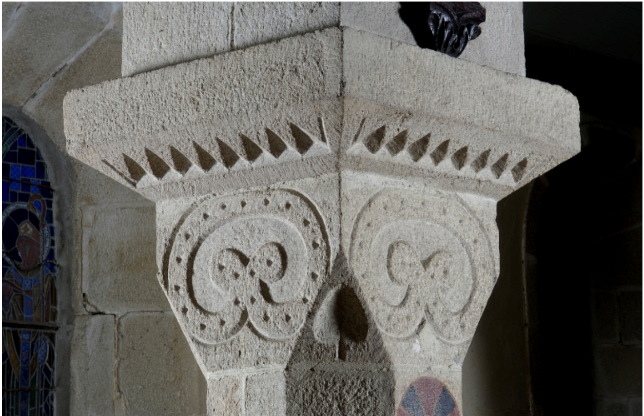
Locunolé, église paroissiale Saint-Guénoé : nef, chapiteau 1, état en 2004
