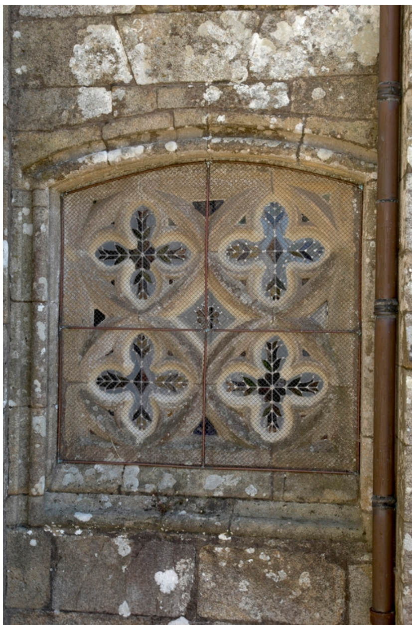
Travée du porche sud, baie à réseau en quadrilobes
