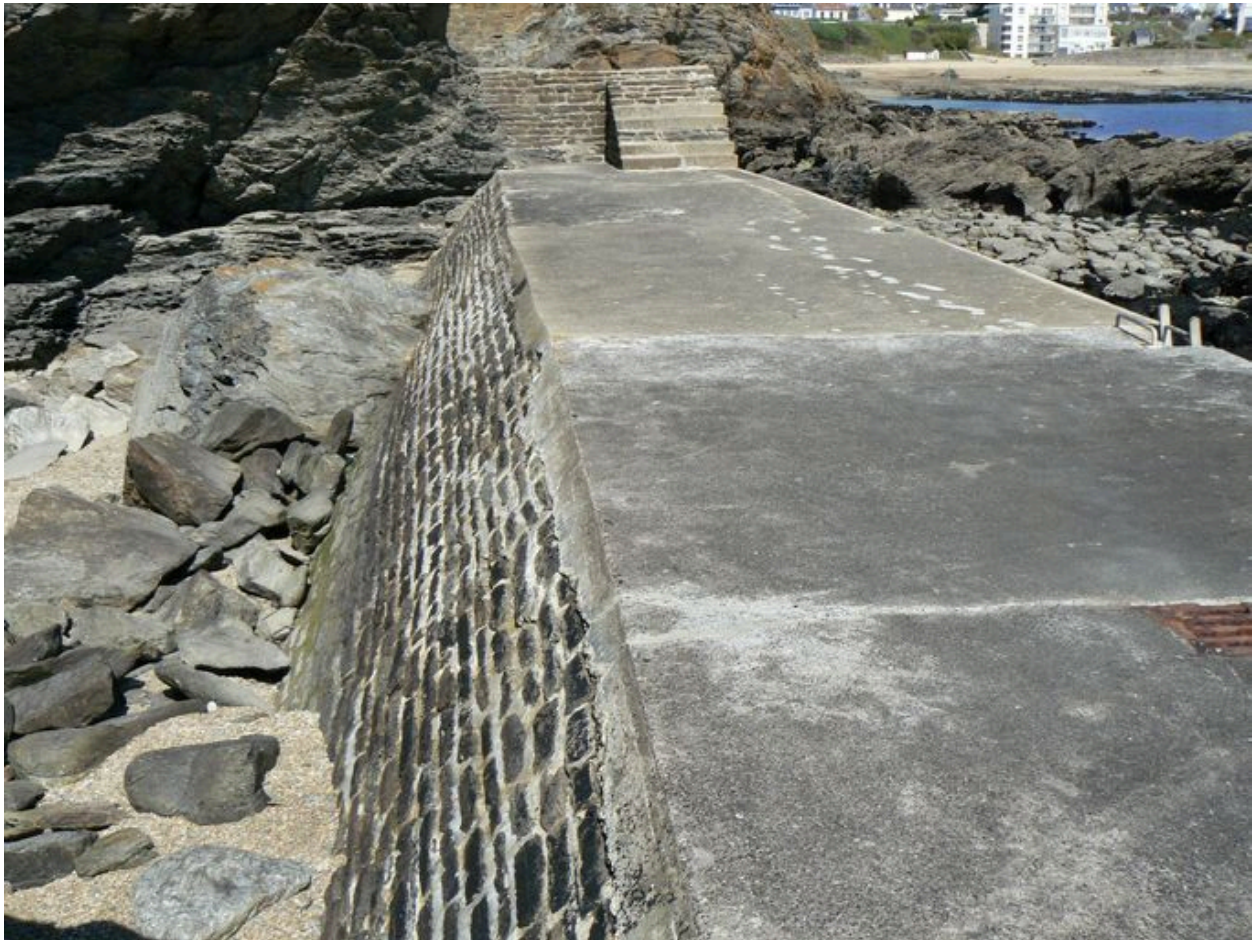
Plateforme, escalier et partie supérieure de la cale des Grands-Sables
