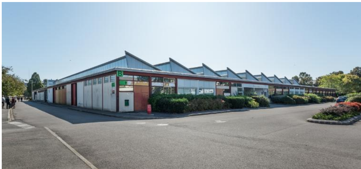
Bâtiment B, ateliers, vue d'ensemble prise du nord-ouest. Louis Arretche et Jean Monge, architectes, plans 1959.
