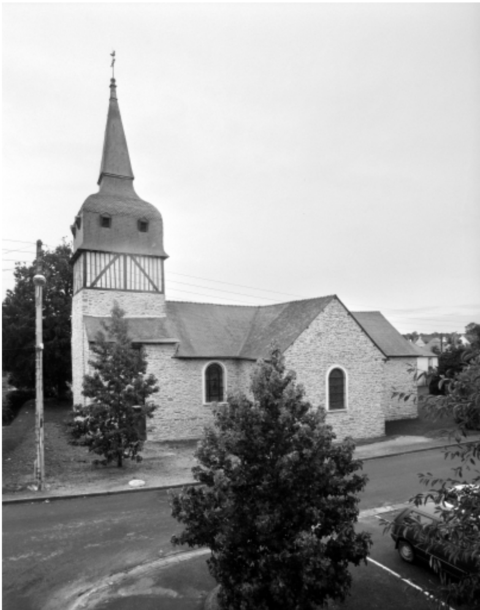
Elévation sud : vue générale
