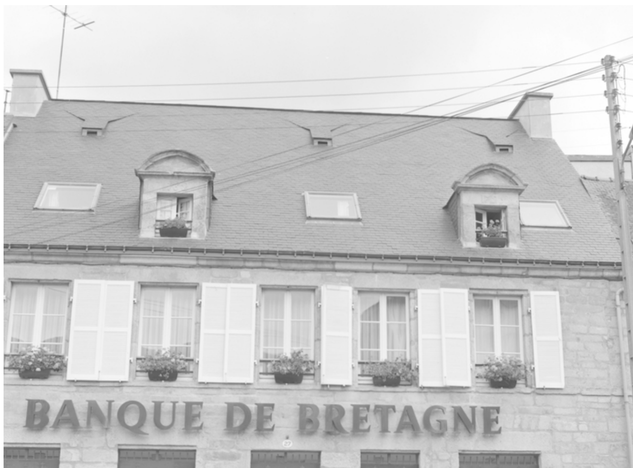
27 rue de Lourmel, lucarnes, détail.
