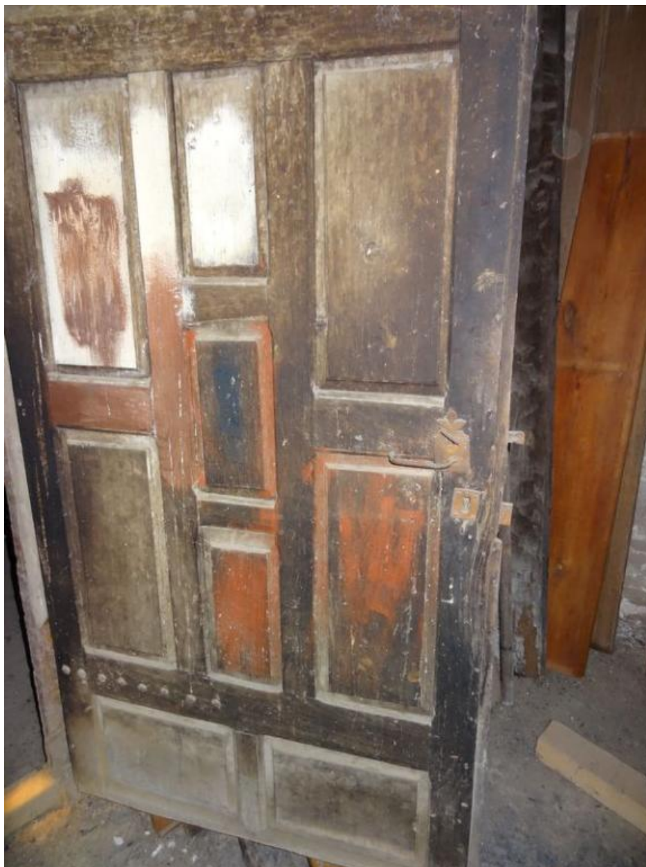
Porte de la cloison sud du comble
