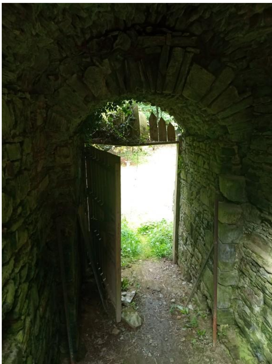
Vue de la porterie ouest : passage d'entrée et escalier
