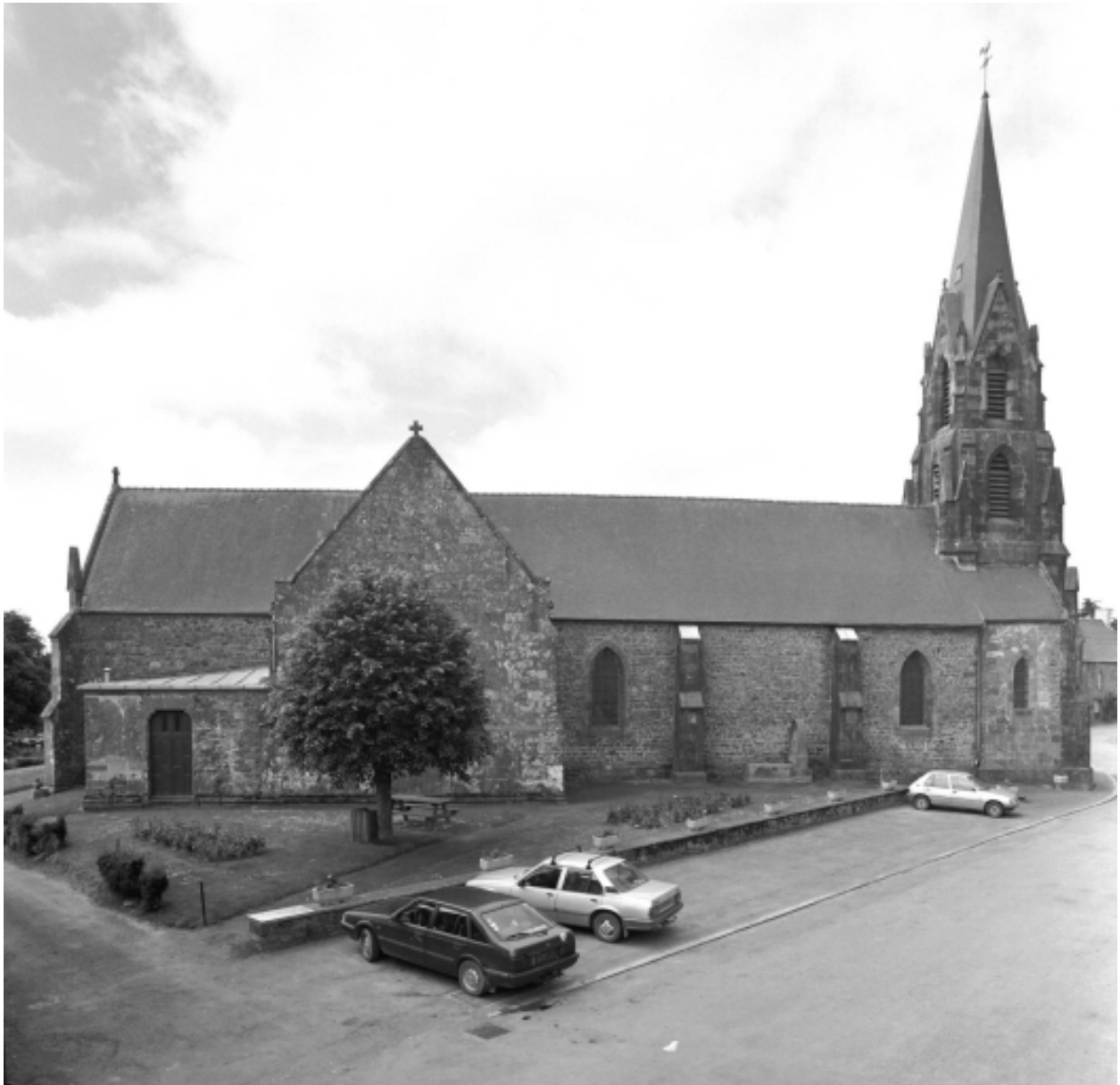
Vue générale nord
