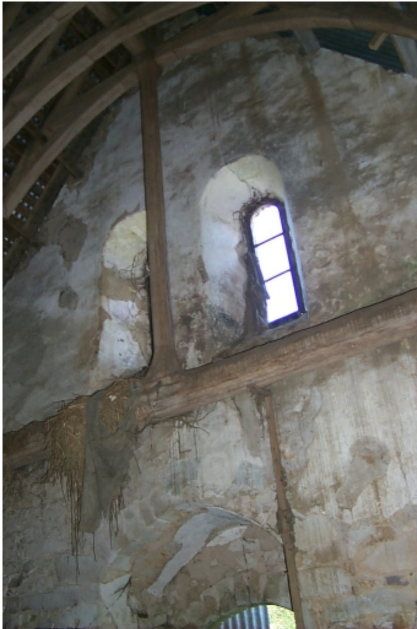
Intérieur, revers de la baie géminée ouest
