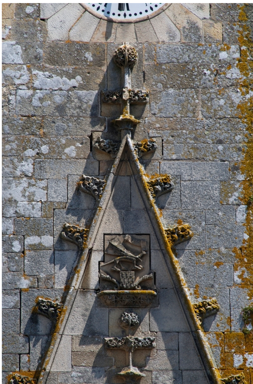
Détail du gâble surmontant le porche ouest
