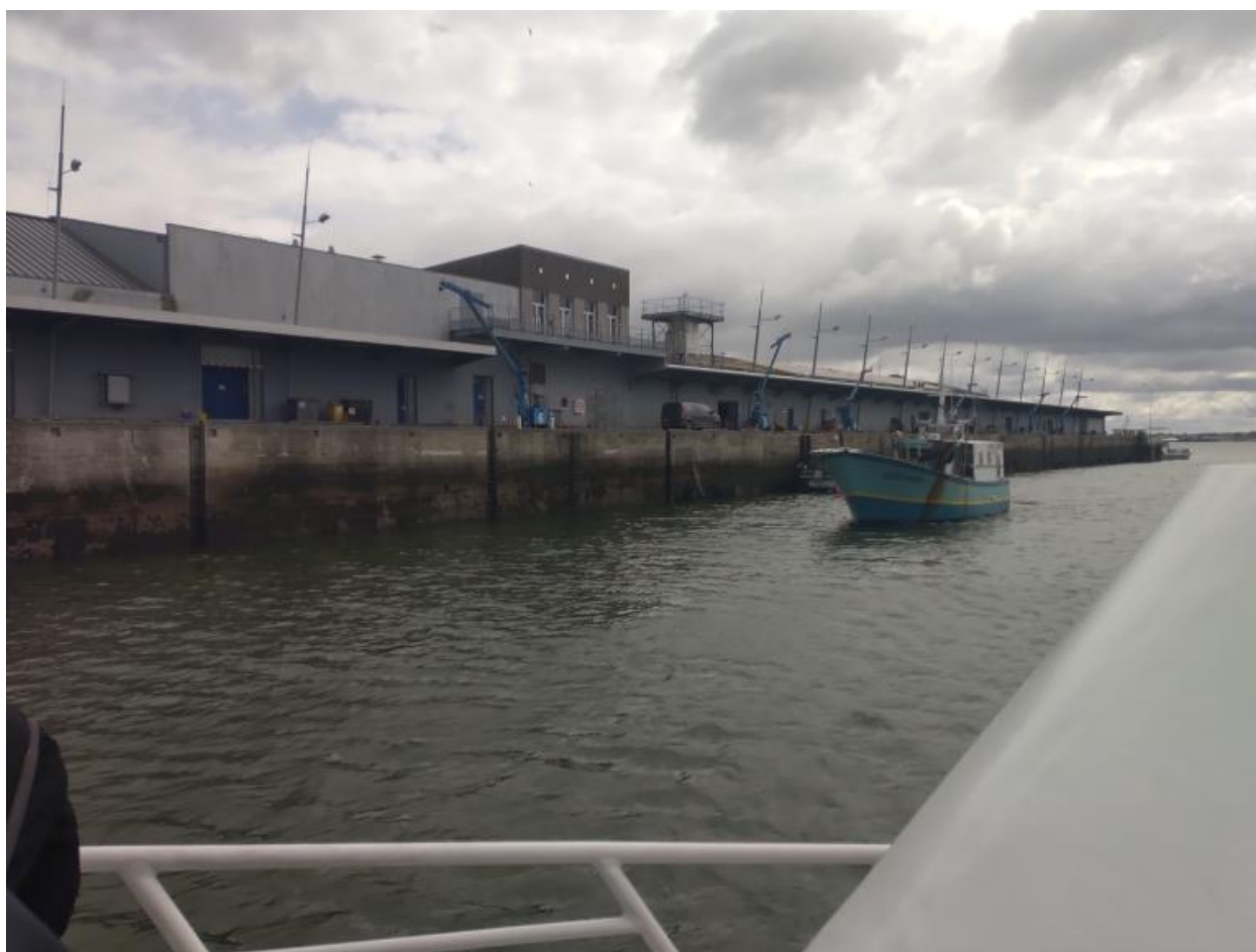
Bateau entrant sur le bassin long
