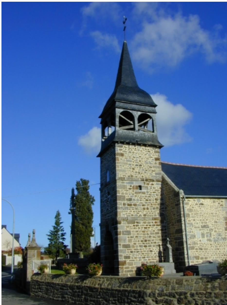
Le clocher : vue générale sud-ouest
