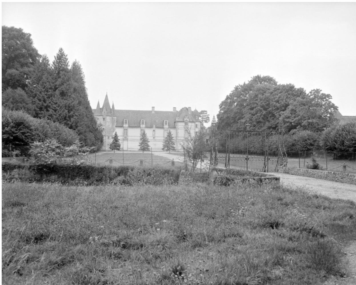
Vue générale, façade principale.
