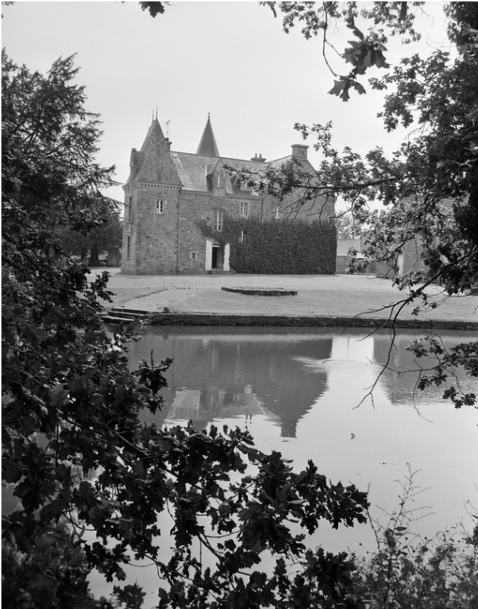
Logis, élévation ouest.
