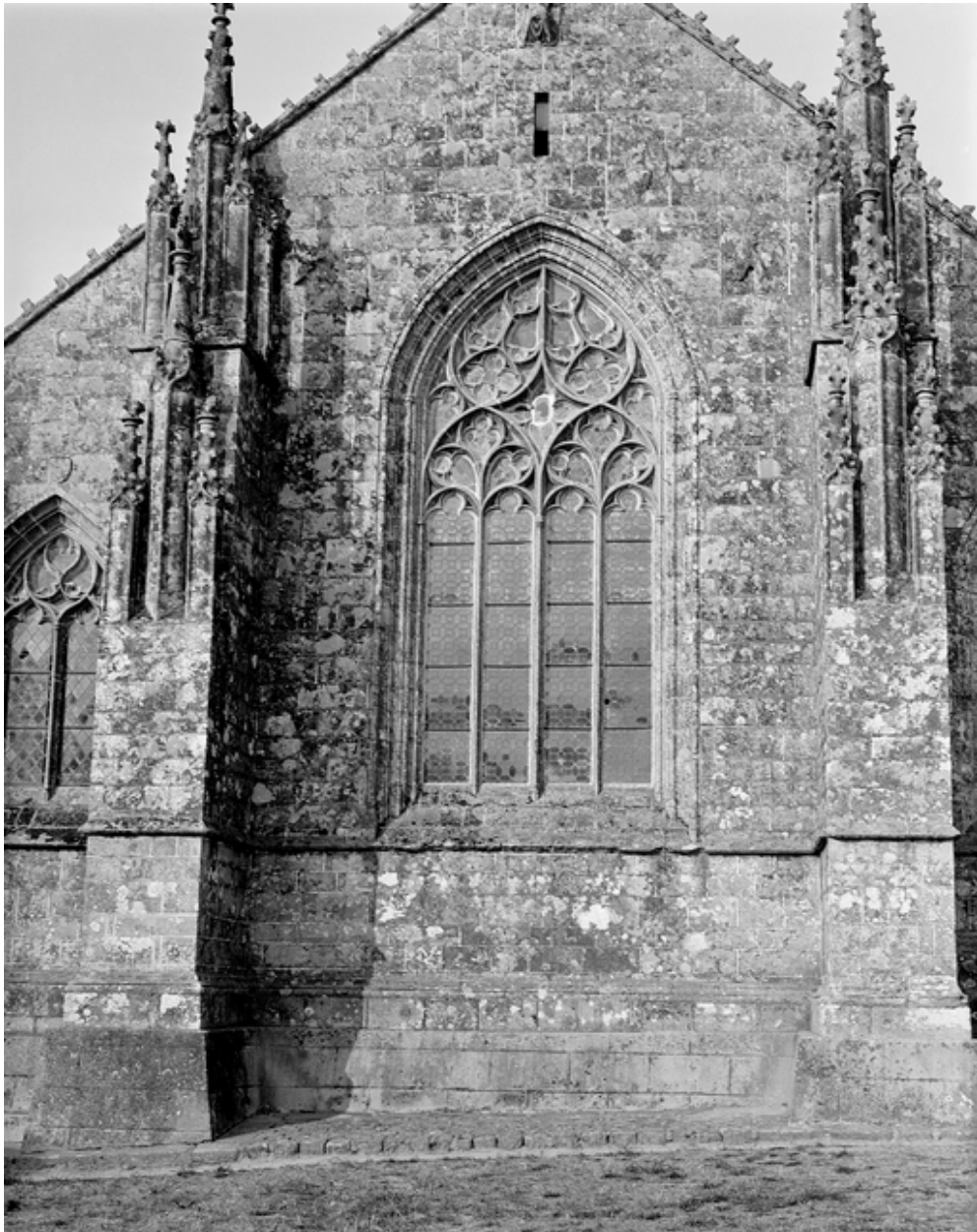
Façade est, détail de la maîtresse-vitre.
