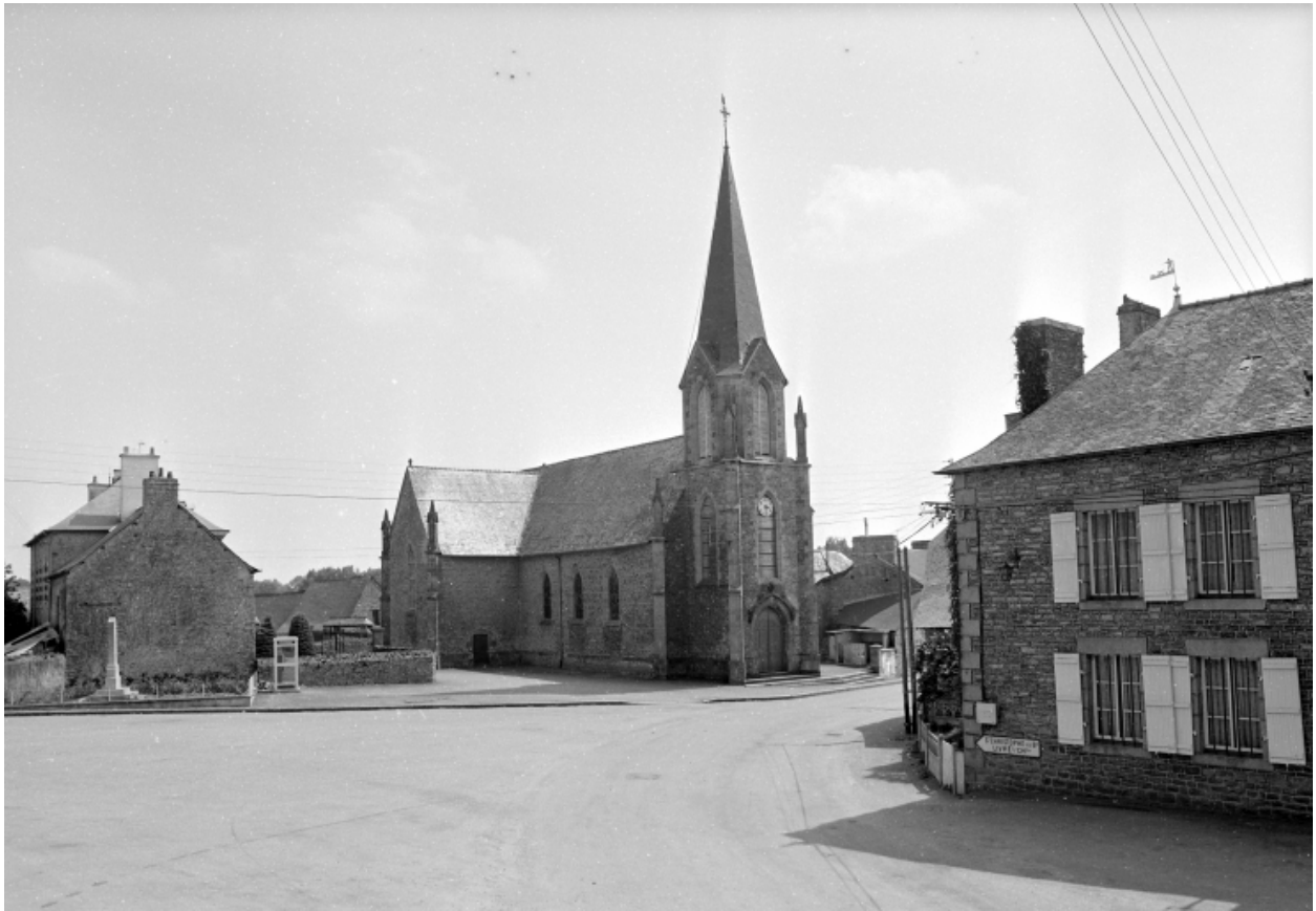
Vue générale prise du nord-ouest
