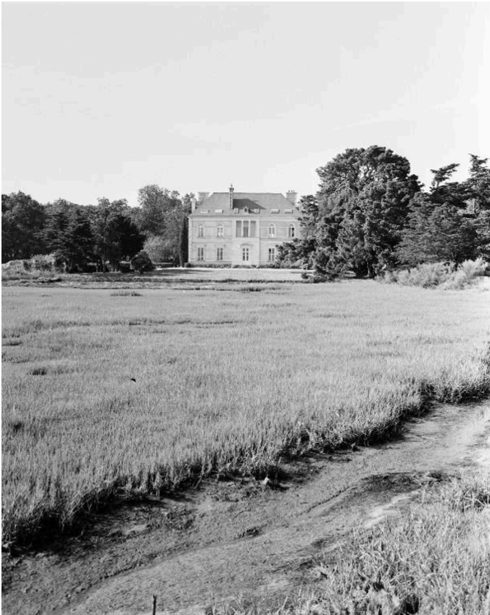
Vue générale nord.
