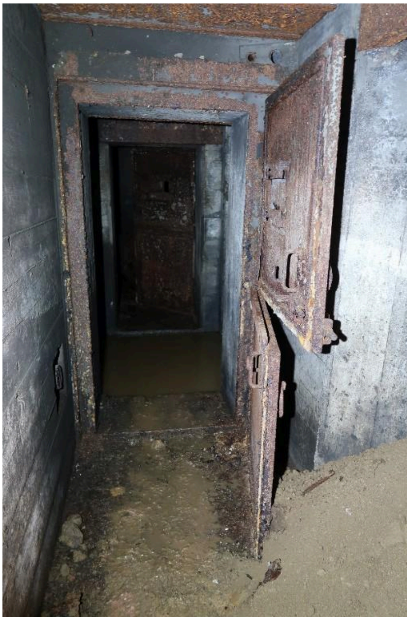
Vue de l'entrée du sas depuis le sud avec sa porte blindée à deux vantaux
