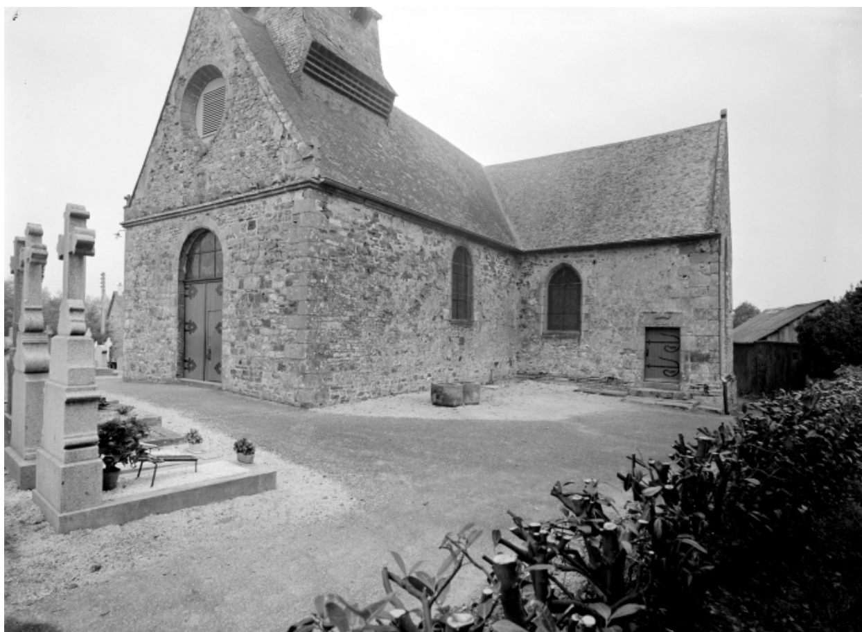
Elévation sud-ouest : vue générale
