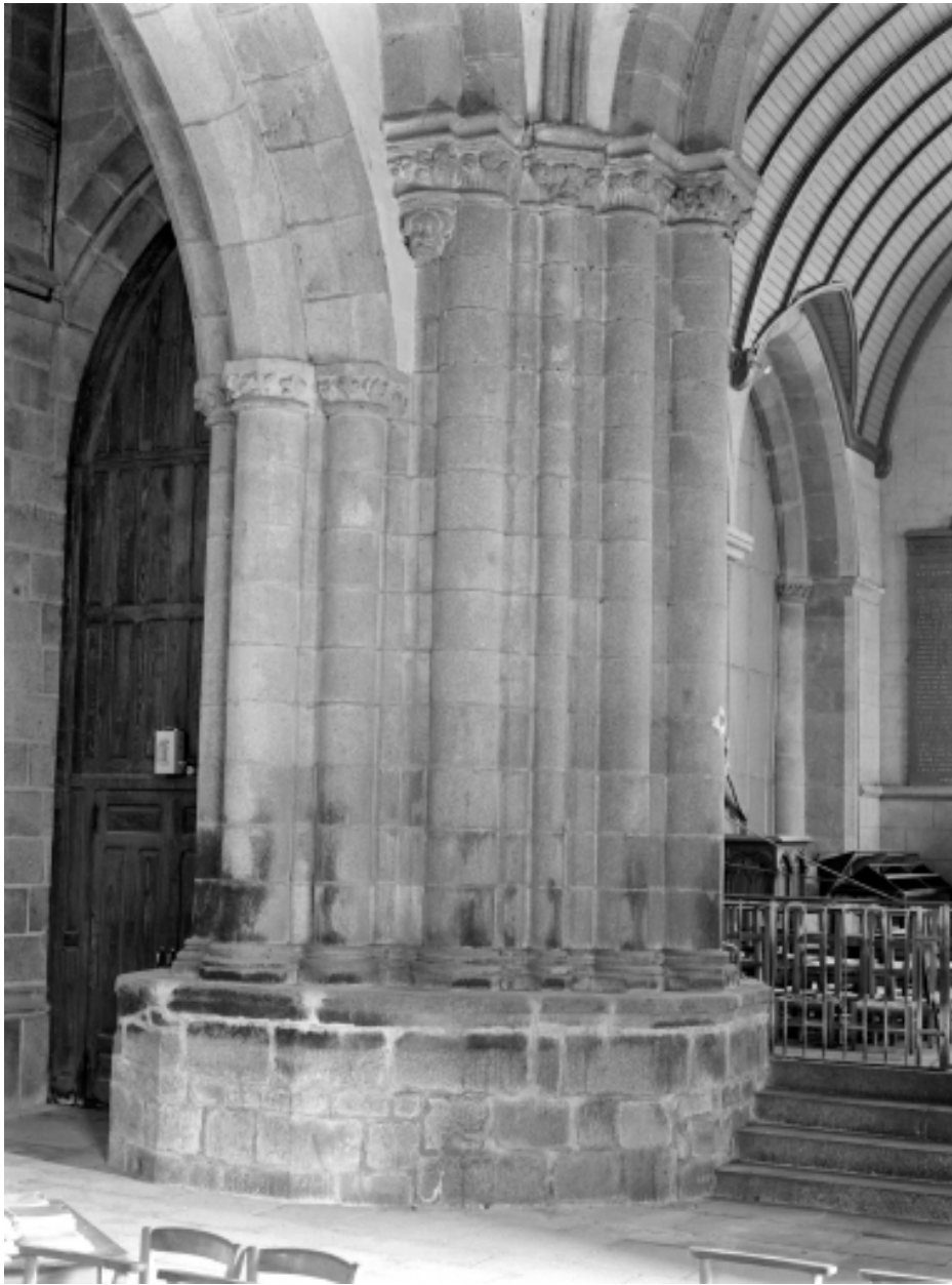
Intérieur, coté Sud, pilier n°2 : vue générale.
