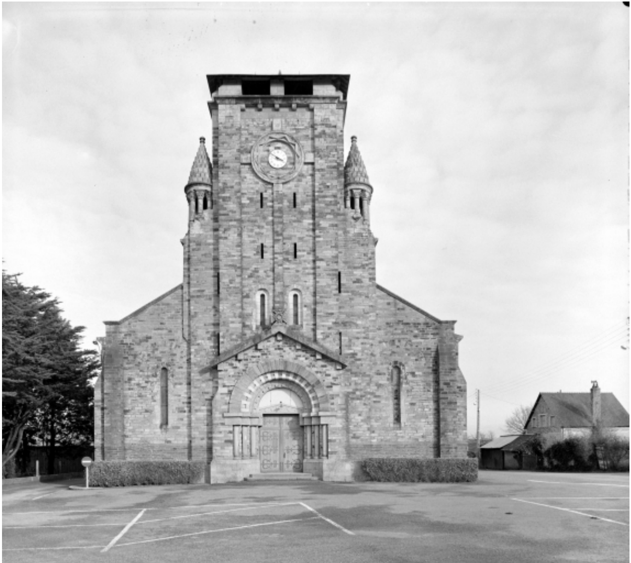
Elévation Ouest : vue générale
