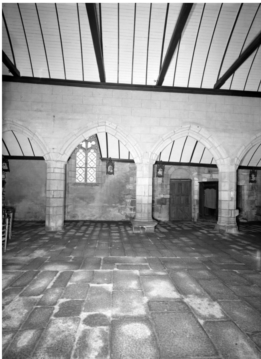
Arcades du mur sud de la nef au niveau de la porte du porche
