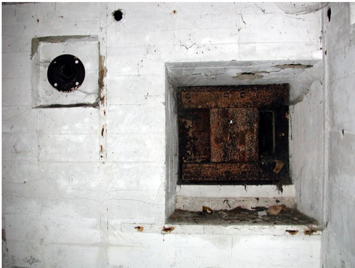
Vue de la salle de garde / pièce de vie : créneau blindé défendant l'entrée (état en 2002)
