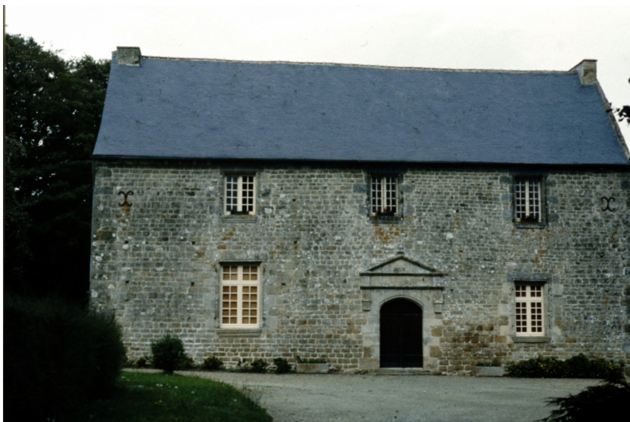
Façade antérieure, vue générale.
