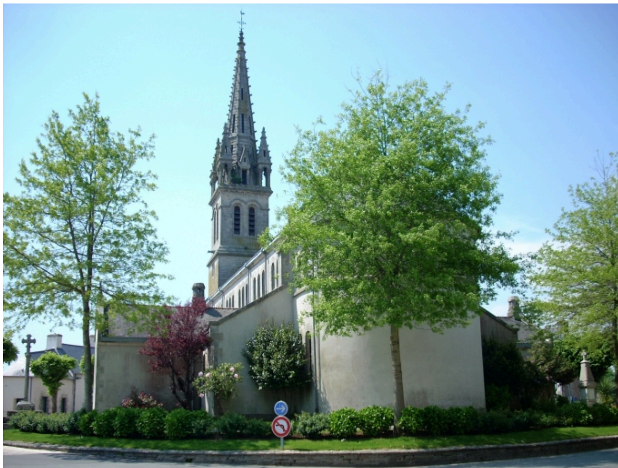
Plomelin, église paroissiale : vue générale est
