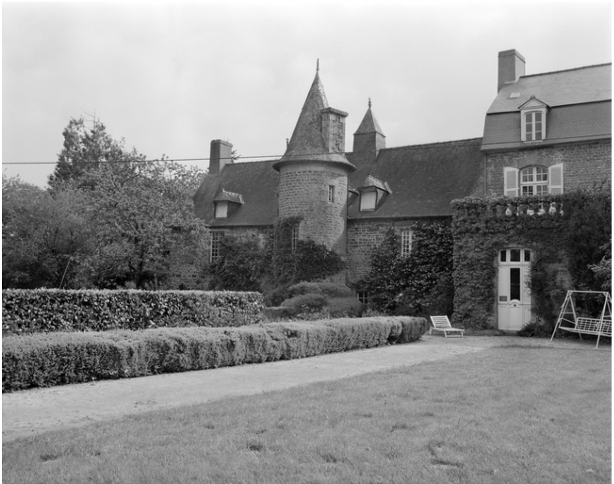
Façade postérieure : vue générale.
