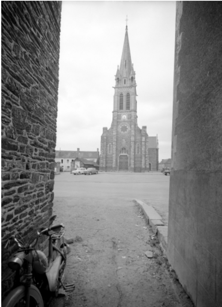
Elévation Ouest : vue générale
