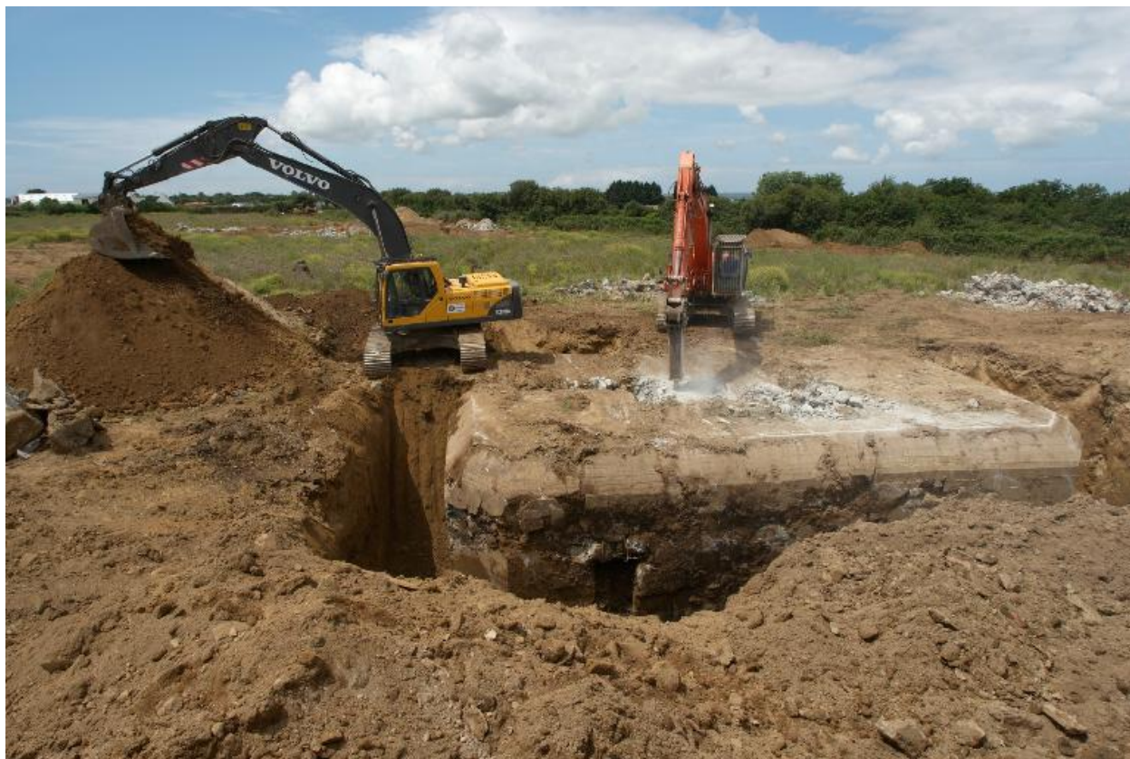
Déconstruction d'un bunker de type 502
