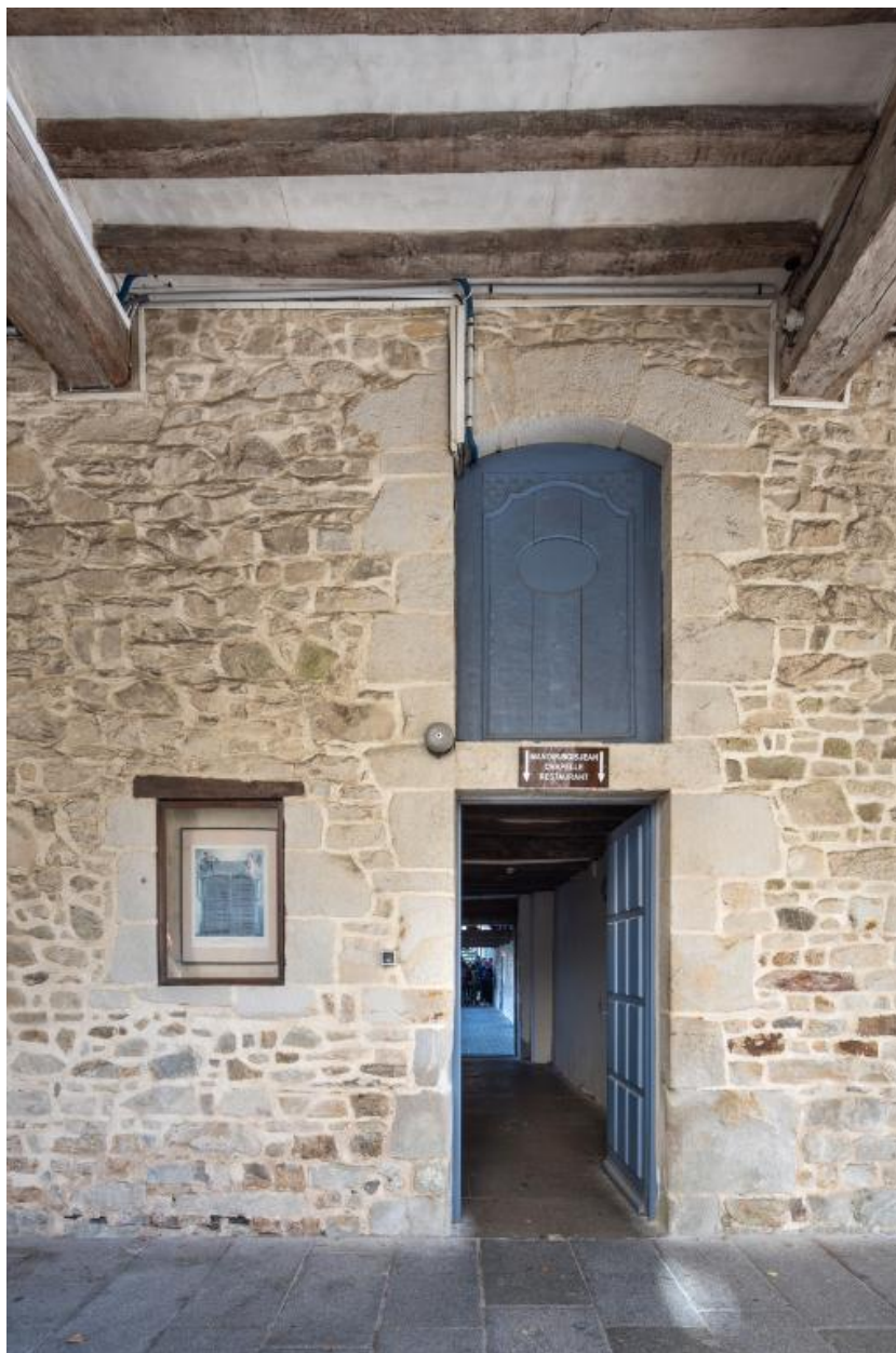
Bâtiment A (administration) : le cloître de l'ancien couvent d'Ursulines. Détail de l'aile est.
