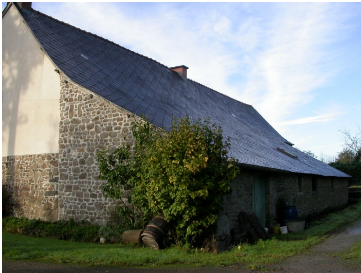
Vue nord-ouest : le cellier
