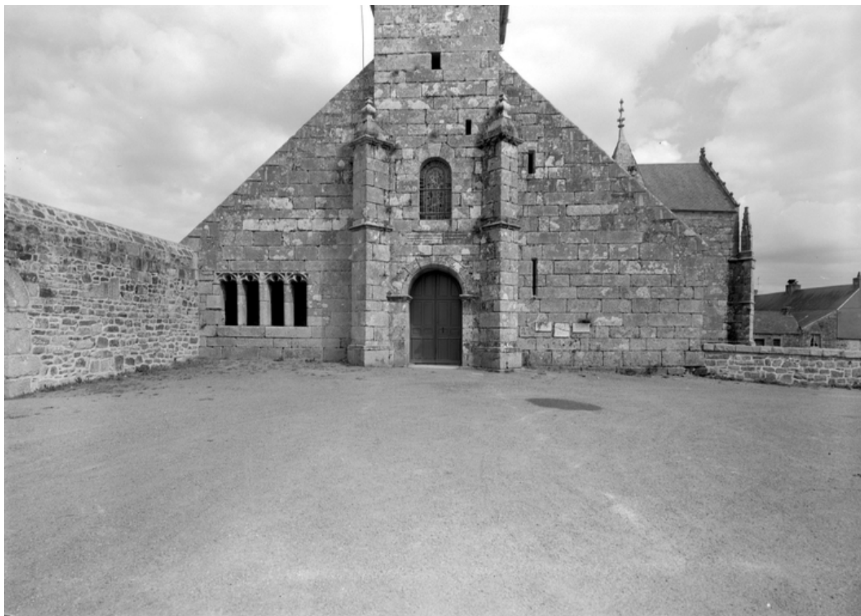
Vue générale du pignon ouest
